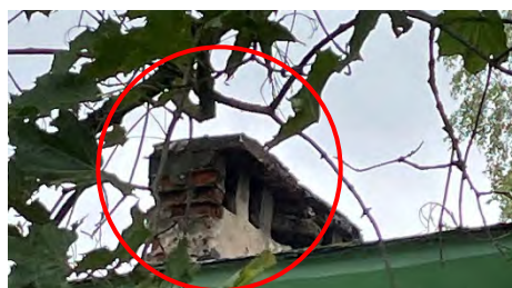
разрушенный оголовок дымовых и вентиляционных каналов
