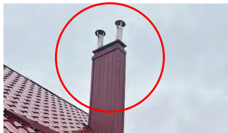
установка зонтов на дымовых каналах
